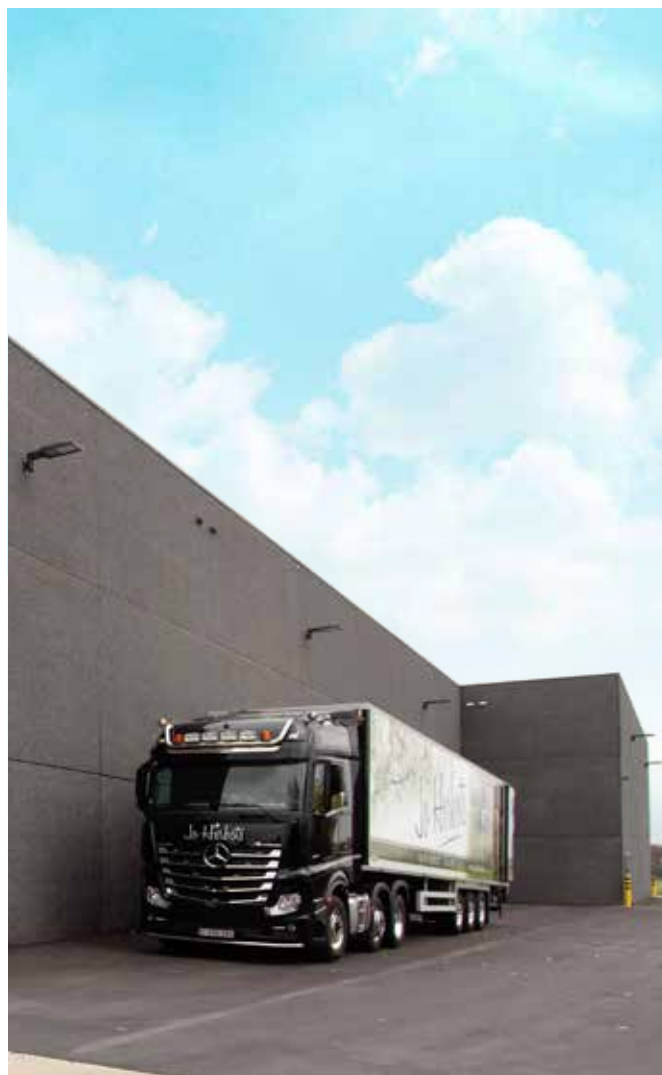
Met een gevel in zwarte silex is het industriële gedeelte een typevoorbeeld van betonbouw.
